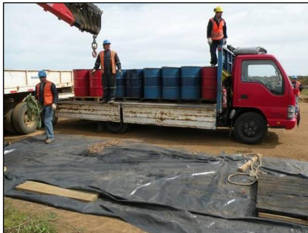
Figura N° 3.3: Ejemplo de apoyo a través de grúa pluma para manejo de residuos peligrosos.
