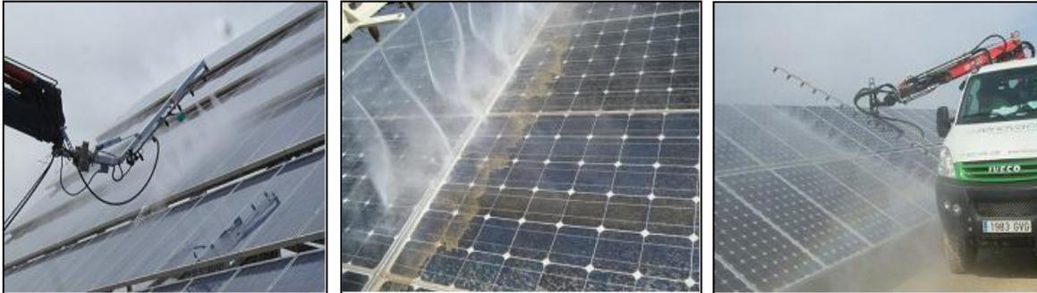
Figura N° 2.7: Limpieza por agua a presión.
