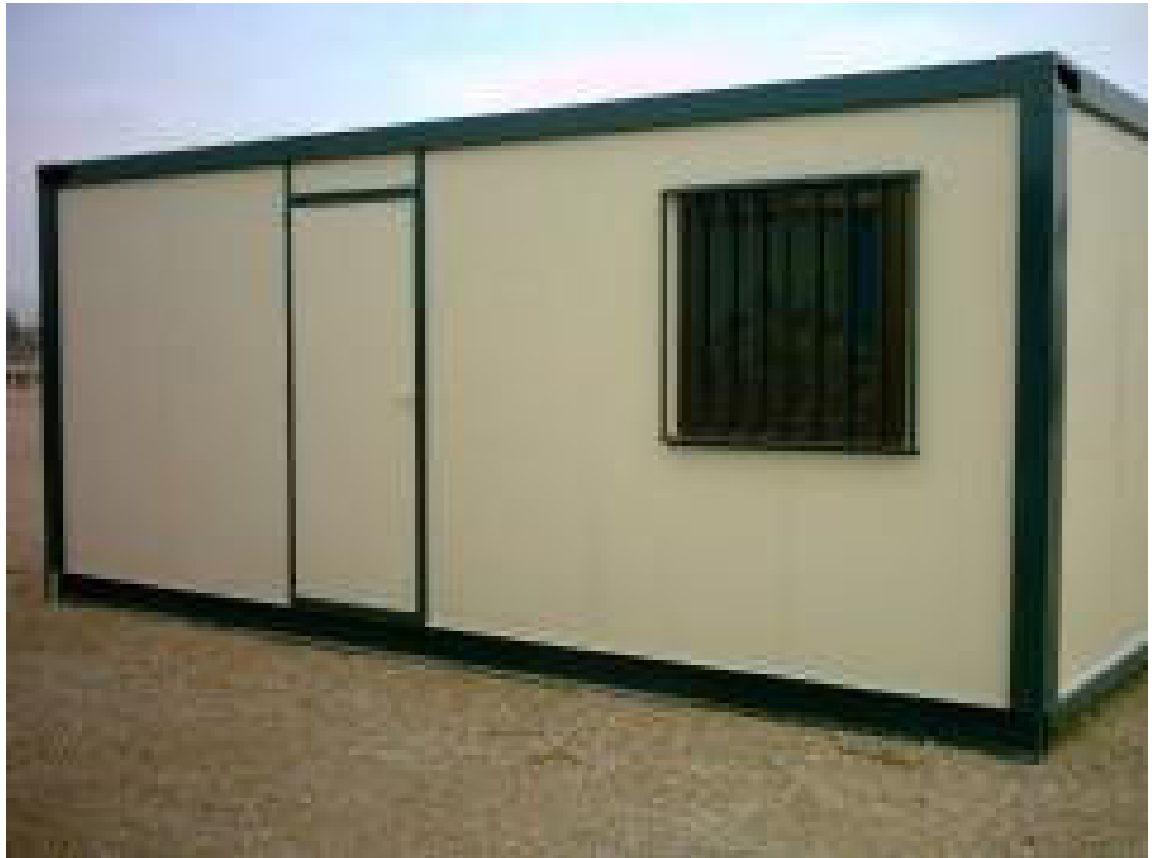
Figura 2.4 > Contenedor prefabricado para instalaciones provisionales de obra
