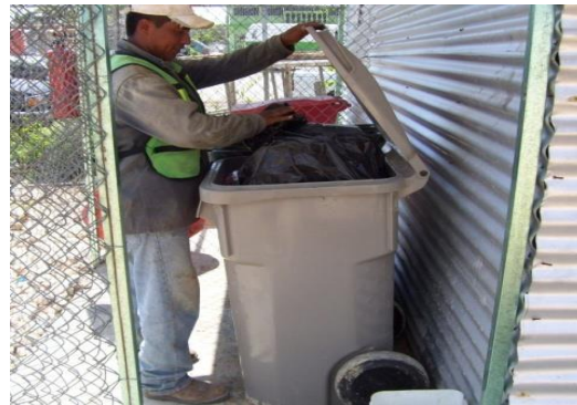
Foto VI.4 Ejemplo de la buena disposición de los residuos sólidos. A) Contenedores con tapa adecuados para el confinamiento temporal de los residuos sólidos urbanos generados; B) Buenas prácticas por parte de los trabajadores de la obra para reducir escurrimiento de lixiviados y malos olores. Fotos: Grupo SELOME S.A. de C.V.
