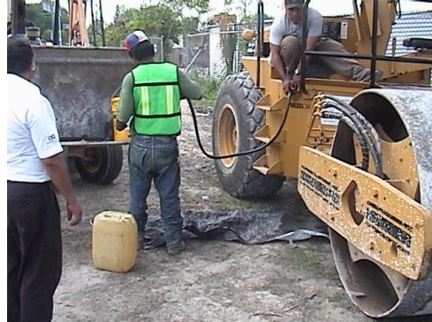
Foto VI.5 Ejemplo de carga de combustible in situ. a) Llenado cuidadoso de gasolina de una bomba para extraer el agua, debajo lado izquierdo se puede observar el uso de una lona para prevenir posibles derrames de combustibles sobre el suelo; b) Carga de diesel a un vibro compactador usando una lona sobre el suelo natural para evitar posibles goteos de combustible y el uso de equipo de protección personal adecuado. Fotos Grupo SELOME S.A. de C.V.
