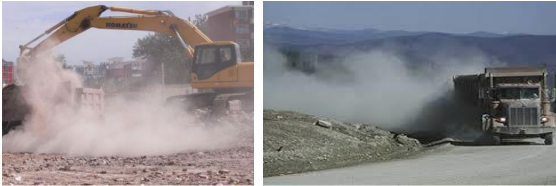
Foto V. 1 Ejemplo de emisiones de partículas y gases que podrían ocasionarse por los trabajos de la maquinaria.
