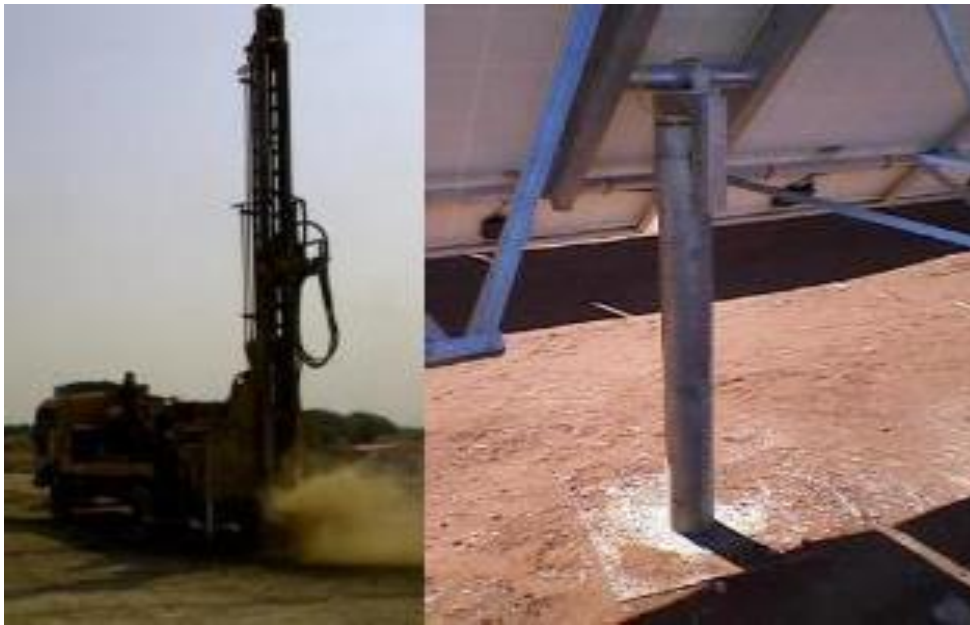
Figura II.10 Hincado de perfiles con maquinaria especializada.
