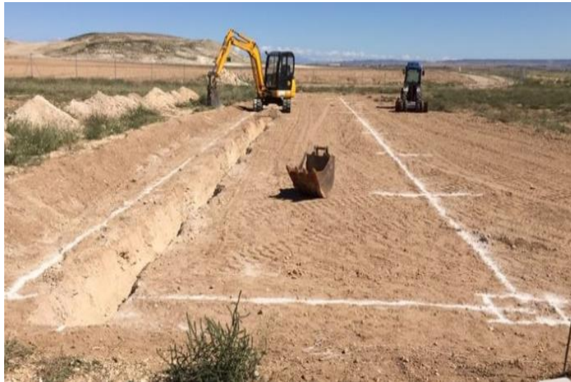
Figura II.11 Ejemplo de excavación de zanjas
