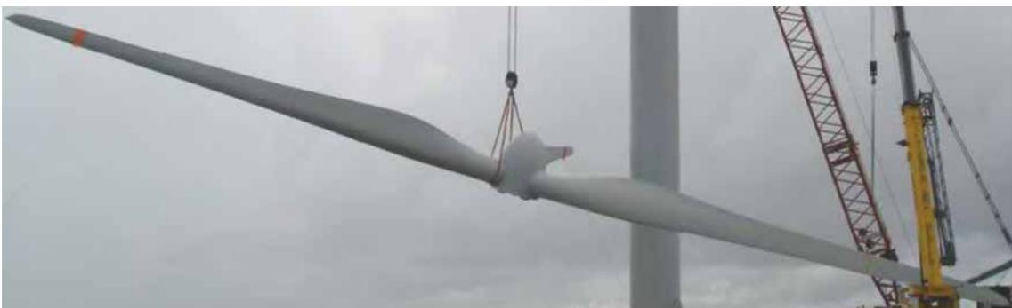
**Figura 11: Montaje de las aspas**
