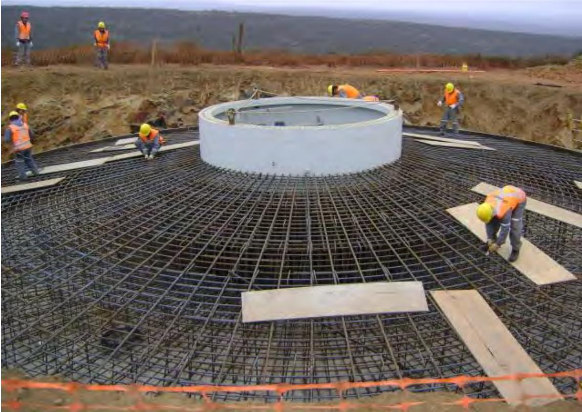
**Figura 10: Construcción de la fundación del aerogenerador**
