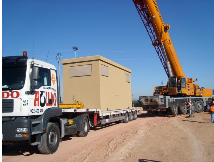
Imagen 12 Proceso de montaje de edificaciones prefabricados
