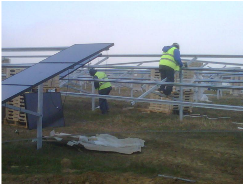
Imagen 10 Proceso de instalación de los paneles solares en estructura metálica
