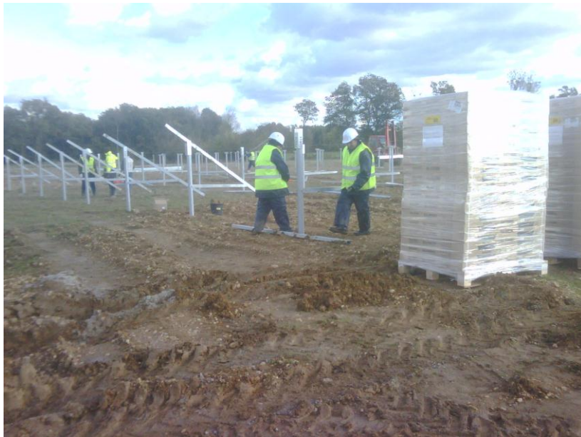
Imagen 9 Presentación estructura metálica soporte de los paneles solares
