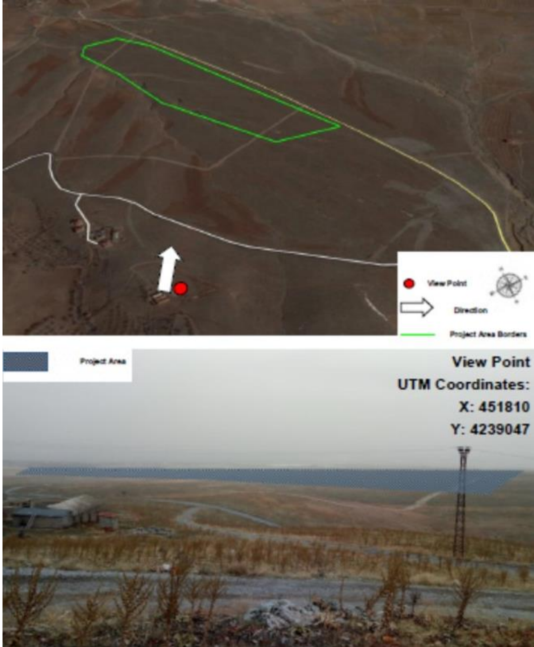
Şekil 2: İota güneş enerjisi santralinin batı görünümü
