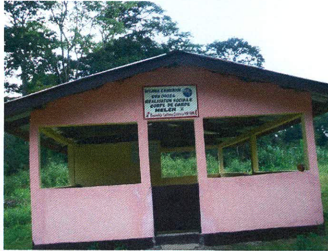
Photo 1 : Corps de garde du village Mélen
