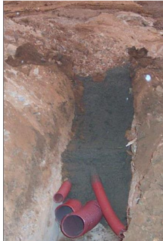
Figure 4-4 : Tranchées des câbles souterrains
