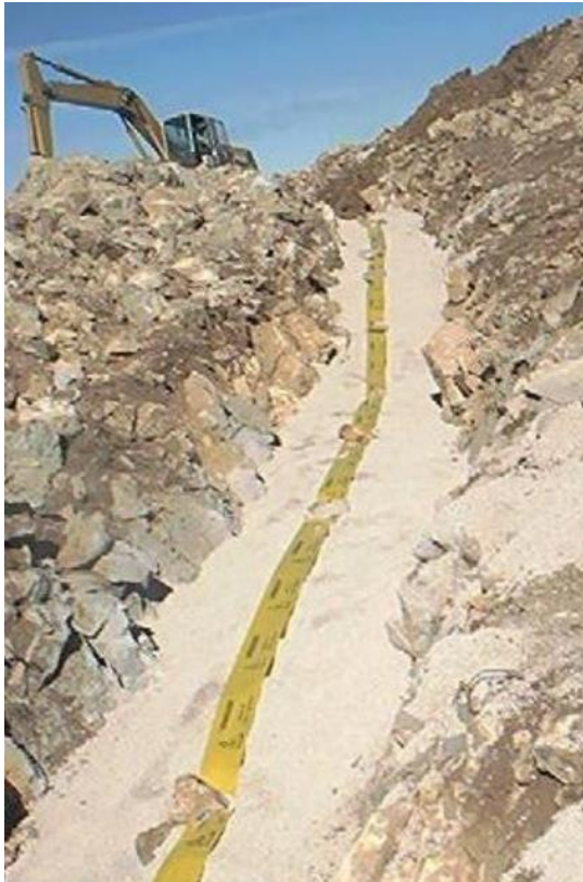
Figure 4-4 : Tranchées des câbles souterrains
