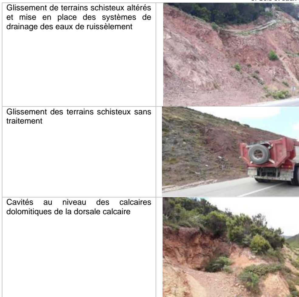
Figure 9-2 : Glissements et instabilités du terrain repérés dans la zone d'étude
