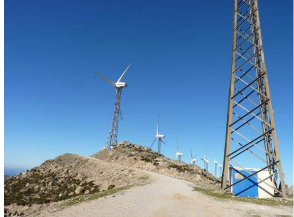
Figure 19-5 : Exemple de piste d'accès aux éoliennes existantes
