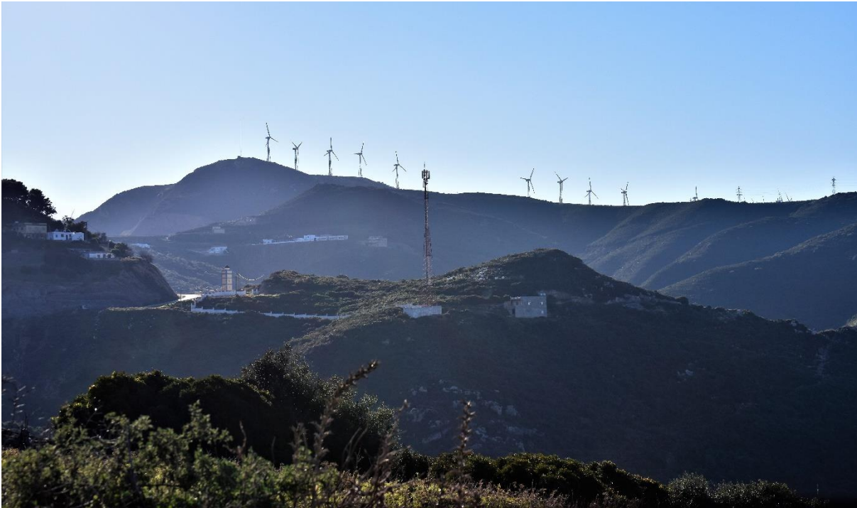
Figure 18-14 : Une vue semi-éloignée depuis la RN16 en direction de Fnideq. Le parc éolien existant est à environ 3,5km à vol d'oiseau
