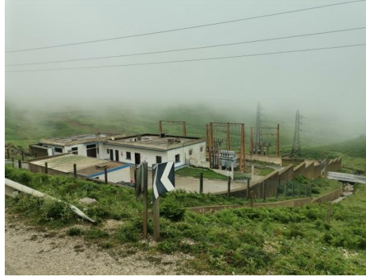
Figure 19-26 : Poste de transfert de l'ONEE existant
