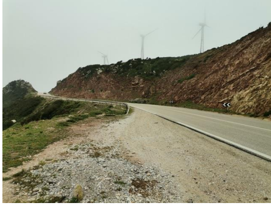
Figure 19-4 : La route provinciale 4703 traversant la crête principale
