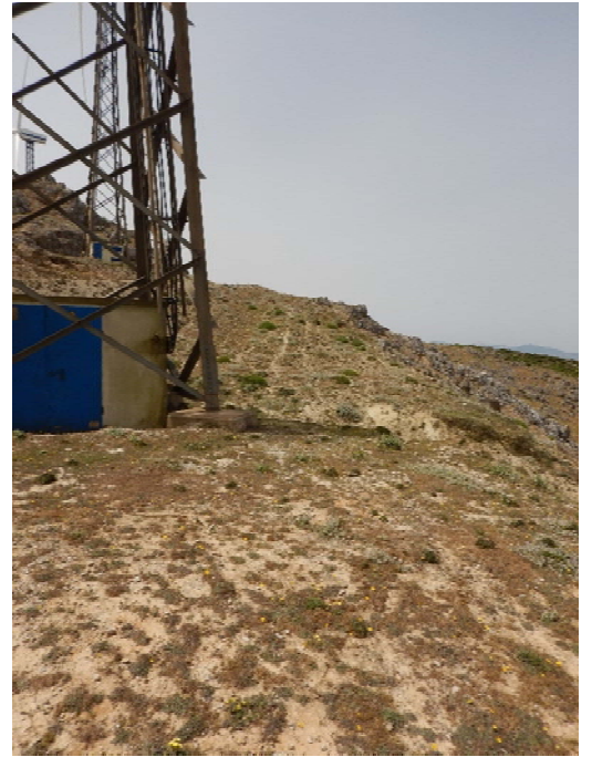
Eoliennes existantes : pelouse écorchée en terrain rocheux
