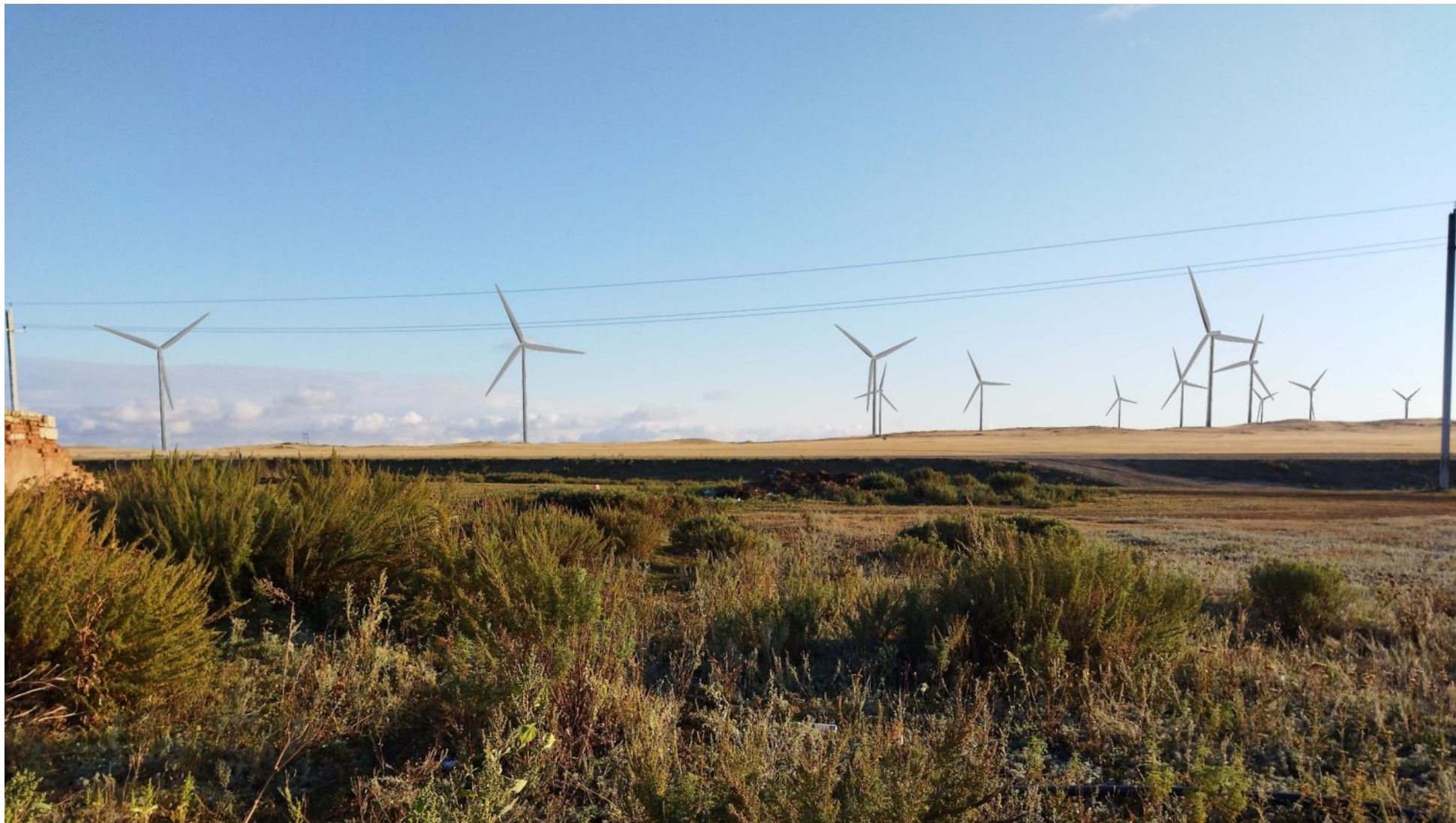
Фото 2 Вид на юго-запад (245°) от дома №1 ул. Абая пос. Булаксай (№4 на Рис. 1)
