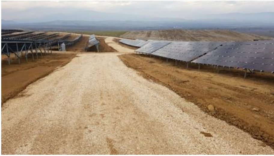
Şekil 2: Amasya Güneş Enerjisi Santralinden bir görünüm
