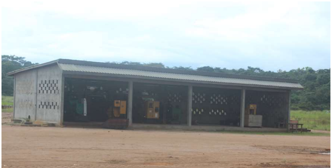
Photo 8 Local groupe électrogène du site industriel
