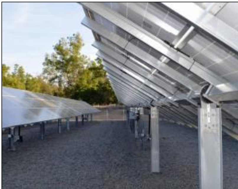
Şəkil 2-8: Tipik izləmə dayaq qurğusunun arxa görünüşü
