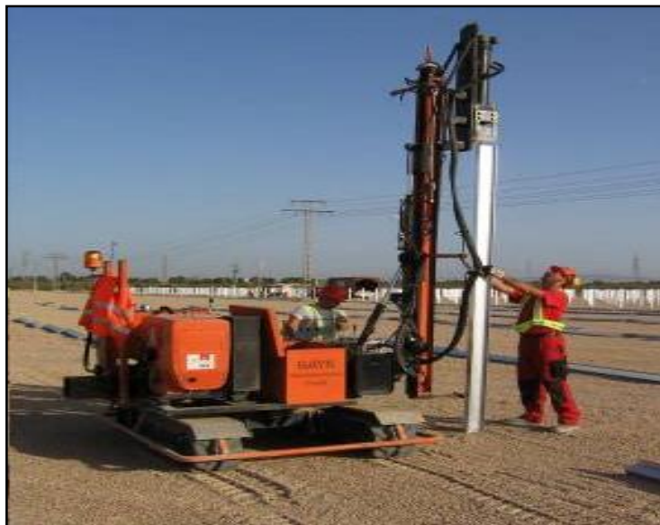
Şəkil 2-9: Svayların quraşdırılması üçün hidravlik svay vurma maşını
