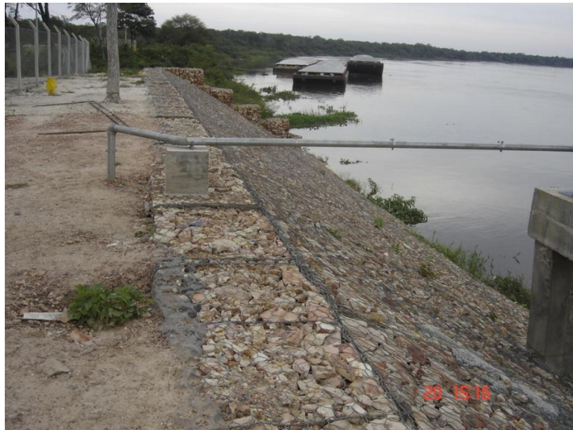
Foto No. 1: Se observa una parte del Puerto, con los dispositivos tipo gaviones para evitar la erosión hídrica hacia el río Paraguay
