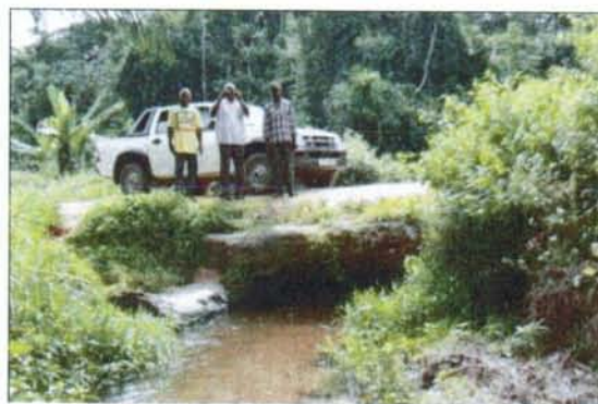
Photo 10 : Pont dans le village de Mbangi
