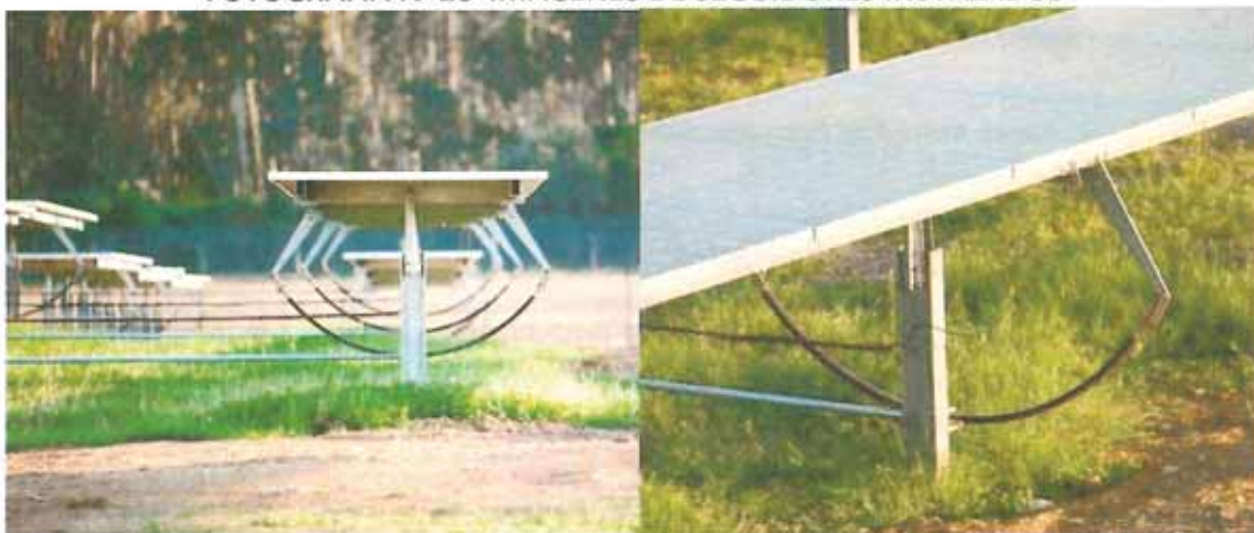
FOTOGRAFÍA IV-16 IMÁGENES DE SEGUIDORES INSTALADOS
