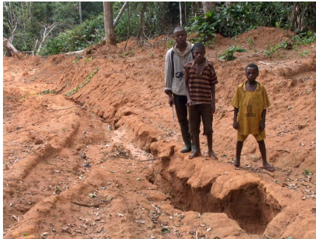
Photo 28 : Erosion sur une ancienne piste
