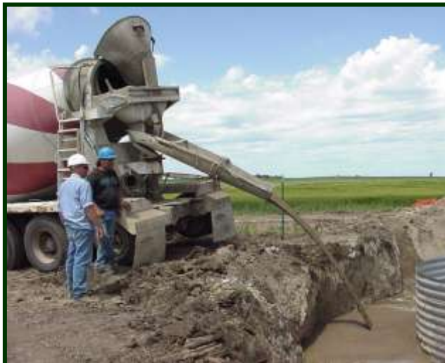
turnarea betonului pentru fundatia unei turbine eoliene
