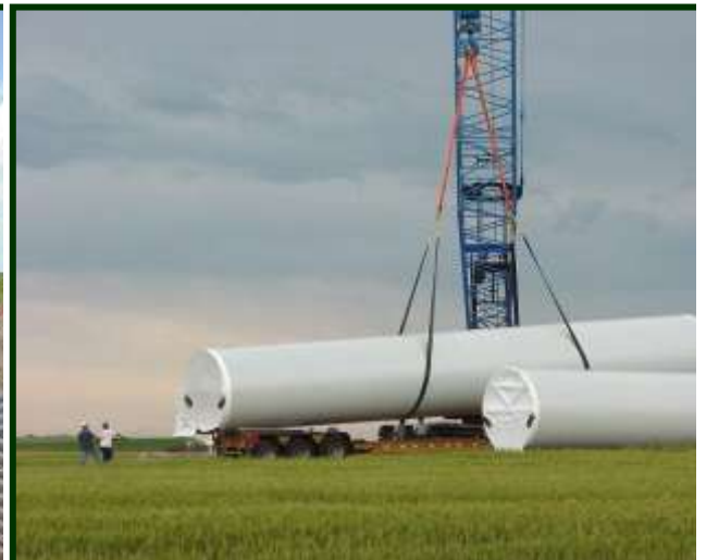
descarcarea subansamblurilor turnului
