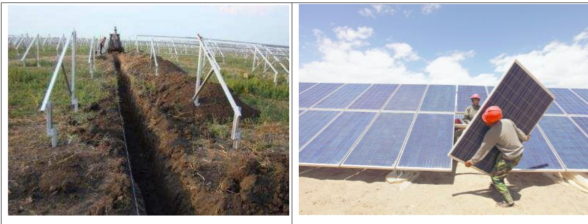
Figura II.24. Montaje de estructura y paneles fotovoltaicos
