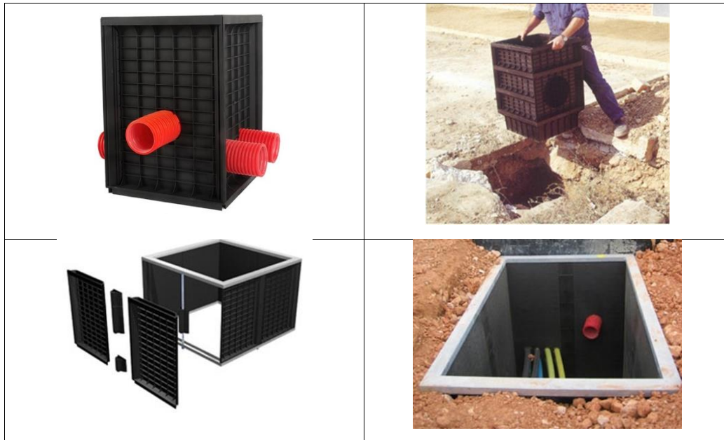
Figura II.21. Instalación de arquetas para canalizaciones subterráneas
