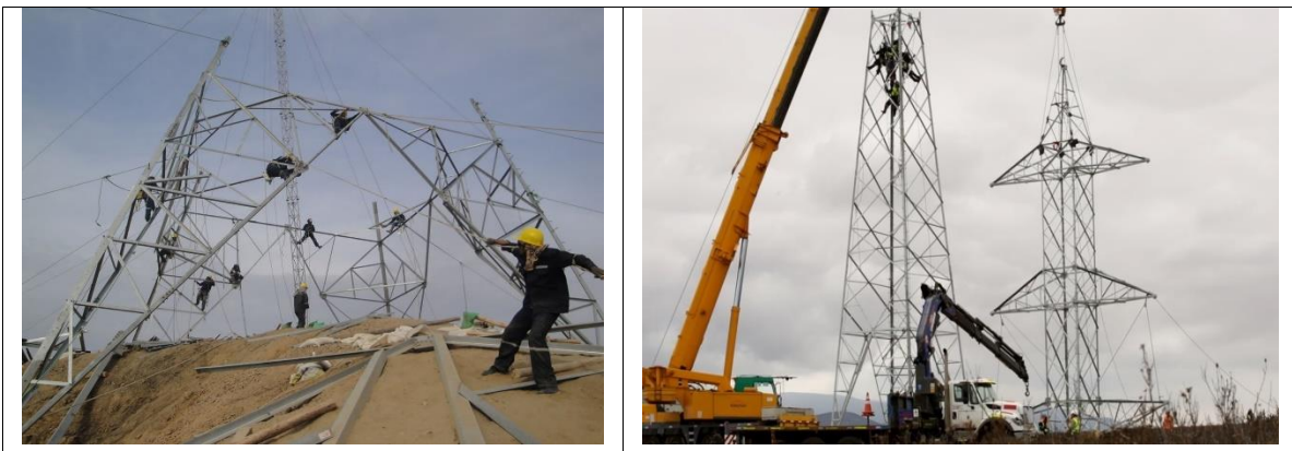
Construcción de torre tipo E71A21
