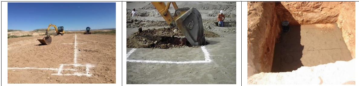
Construcción de cimentaciones de zapatas
