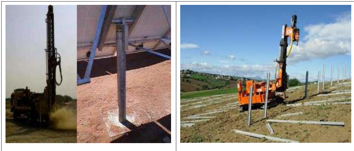
Figura II.20. Hincado de perfiles con maquinaria especializada.
