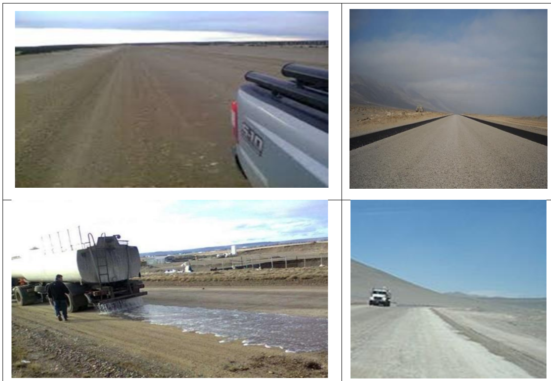
Figura II.22. Fabricación de caminos en la planta fotovoltaica.
