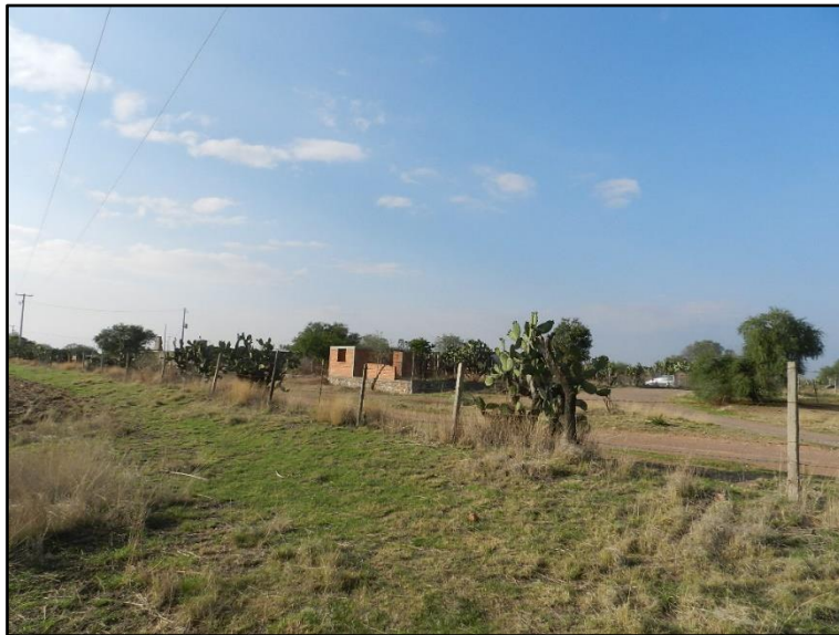
Figura 4. Infraestructura tendido electrico
