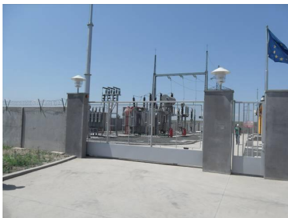
Figura 7: Cladirea de control la situl Parcului Eolian.
