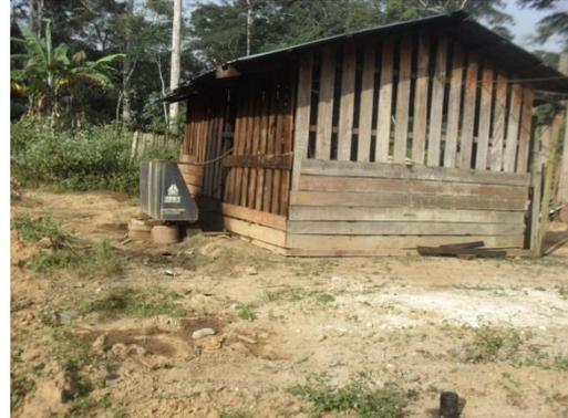
Photo 1 : Case de protection du groupe électrogène à la base-vie de l'exploitation forestière
