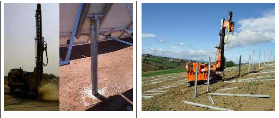
Figura II-24. Hincado de perfiles con maquinaria especializada.
