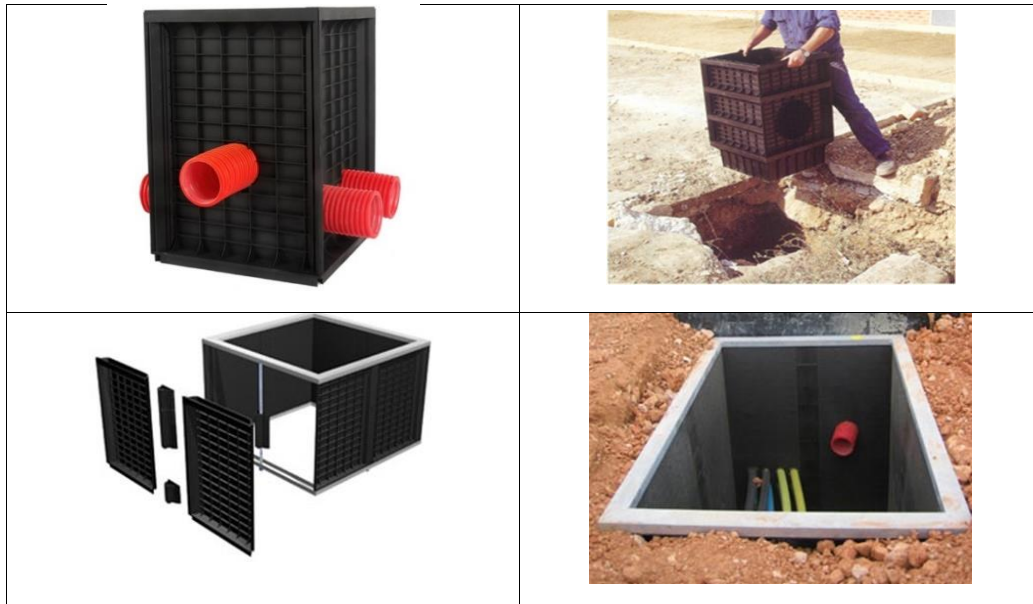
Figura II-25. Instalación de arquetas para canalizaciones subterráneas
