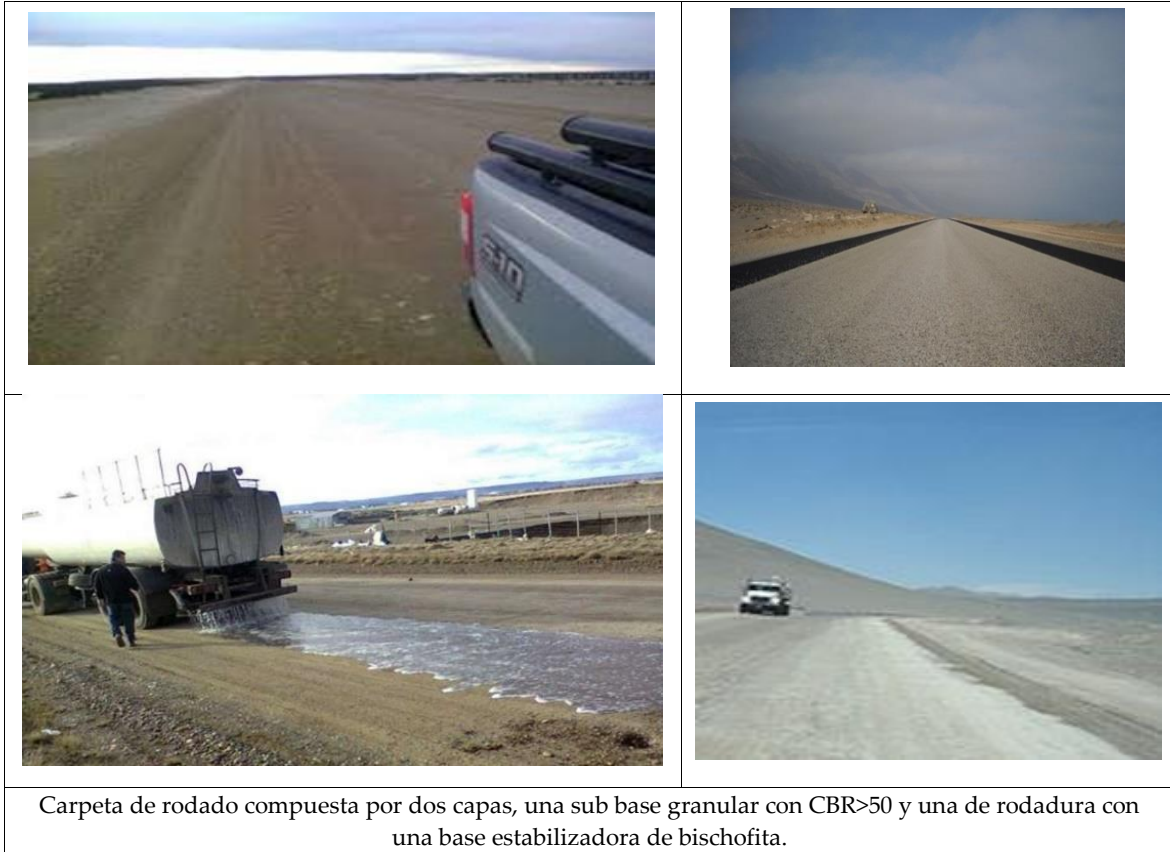
Figura II-26. Fabricación de vías de acceso en la planta fotovoltaica.
