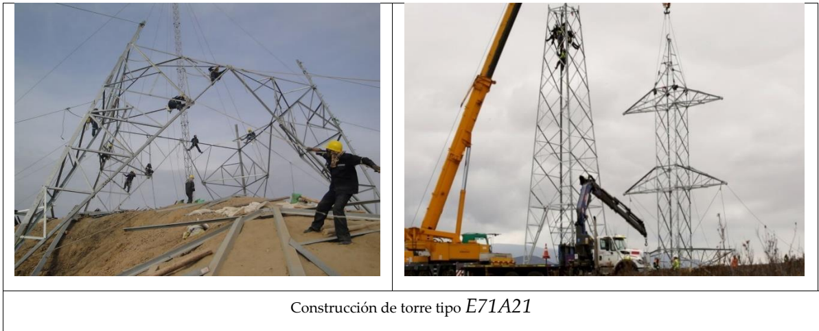
Figura II-34. Montaje y armado de torres de interconexión de alta tensión.
