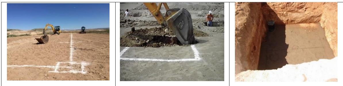
Construcción de cimentaciones de zapatas
