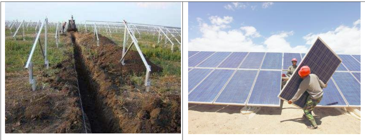
Figura II-28. Montaje de estructura y paneles fotovoltaicos
