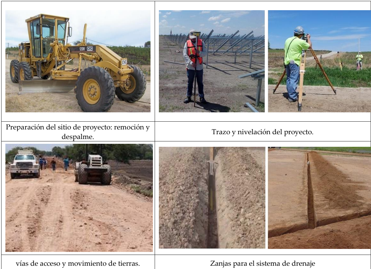
Figura II-23. Ejemplo de trabajos de preparación del sitio para proyectos solares.
