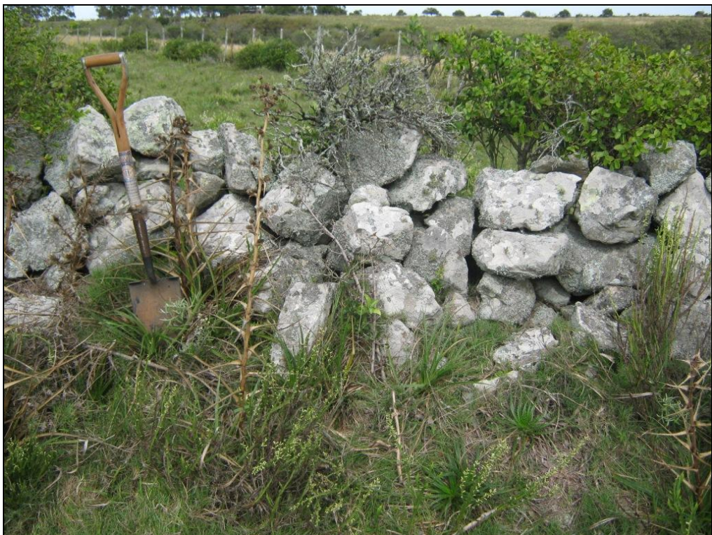
Fig. 12. Detalle de cerco de piedra desmontado y vegetación arbustiva.
