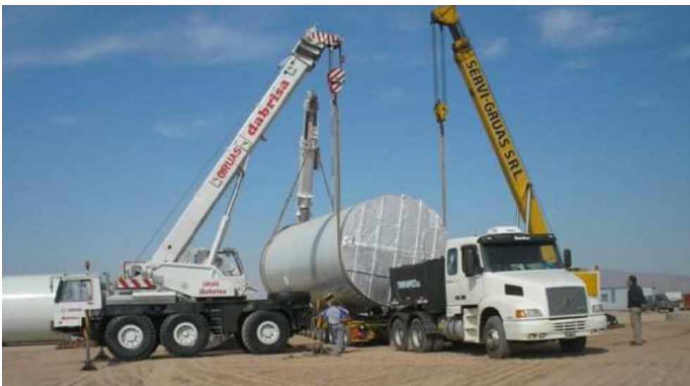
Figura II-9: Montaje de la torre. Fuente IMPSA.
