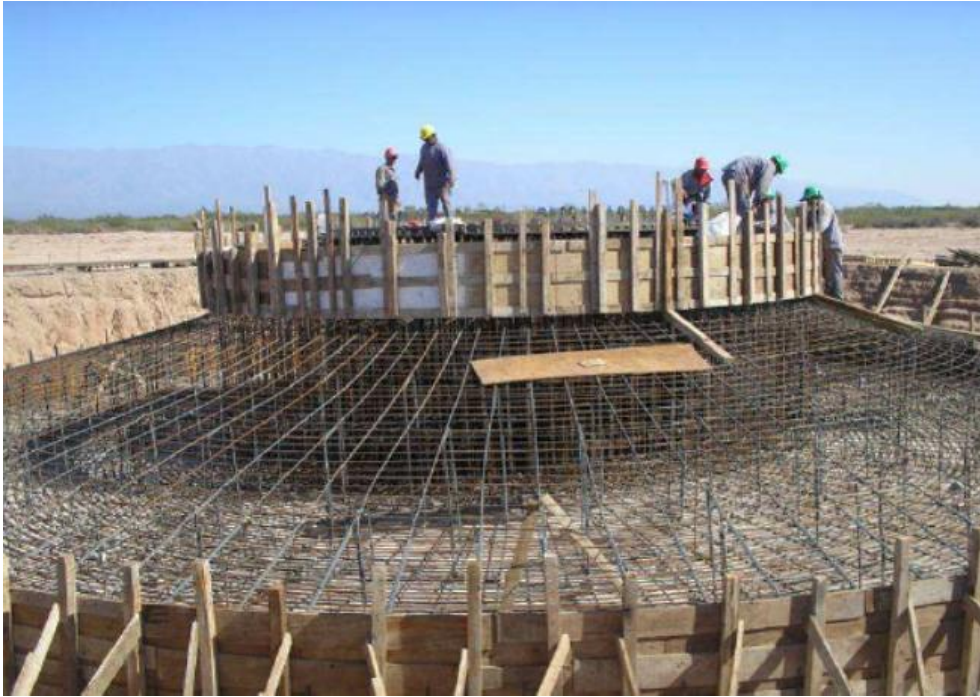
Figura II-7: Construcción de la base del aerogenerador. Fuente IMPSA.
