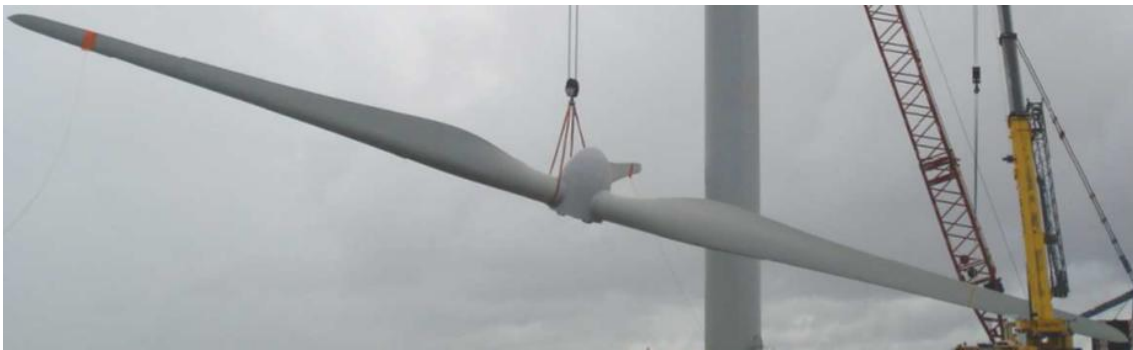
Figura II-8: Montaje de las aspas. Fuente IMPSA.
