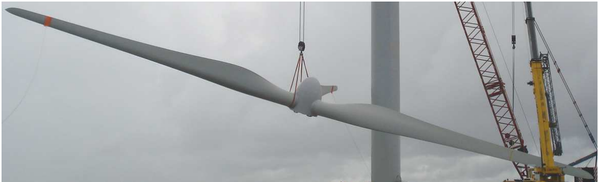
Figura 4 - Rotor del Aerogenerador
