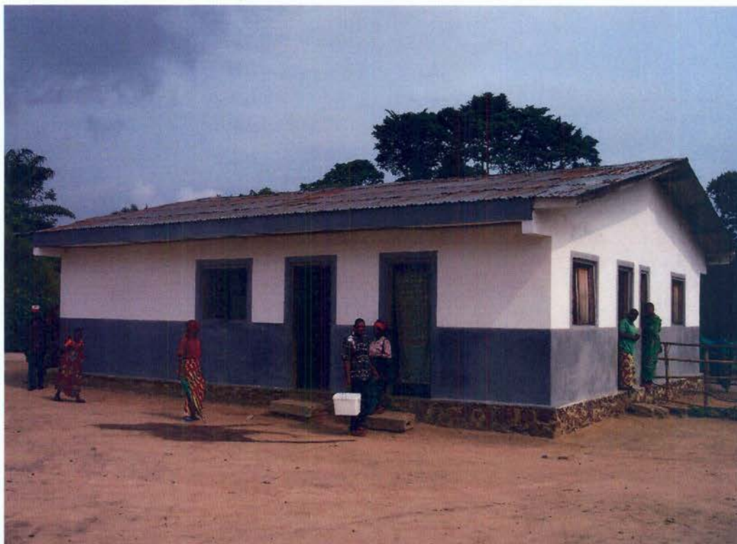
Photo 1 : Centre de santé construit en matériaux durables dans la localité de Djoa par SEFOCO
