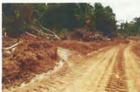
Photo 3 : Route en ouverture, mise en place d'un exutoire
