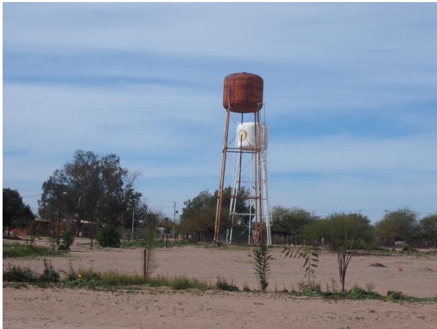
FIGURA 5.3.4.1.2. POZO EJIDAL EJIDO MORELOS.
