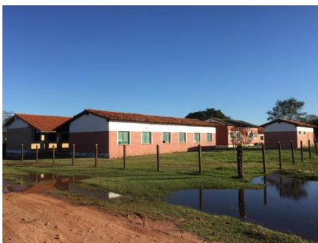
Escuela y Colegio Edelmira Torres Blanco - Paso Mbutu.
