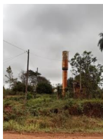
Sistema de Agua Santísima Trinidad
