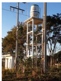
Sistema de Agua Higua Po'i
