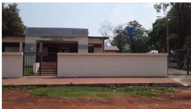
Puesto de Salud Cuartelero -Fuente: Registro fotográfico de trabajo de campo. Equipo consultor. Concepción. Agosto -Septiembre 2020.
