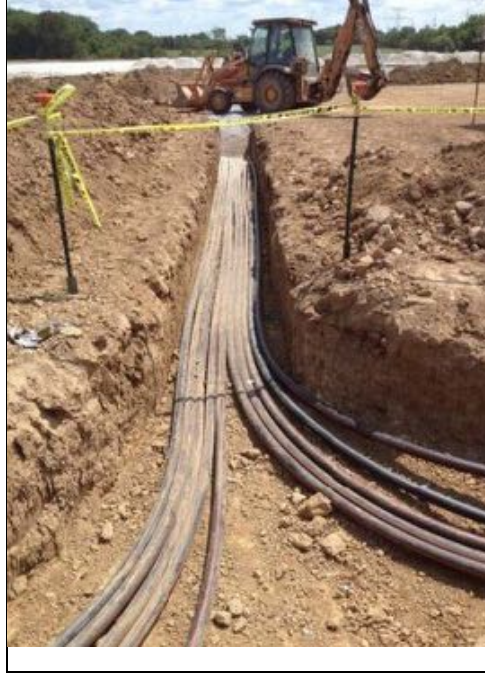
Şekil 3-10. Benzer Bir Projede Açılan Kablo Hendeklerini Gösterir Fotoğraf
