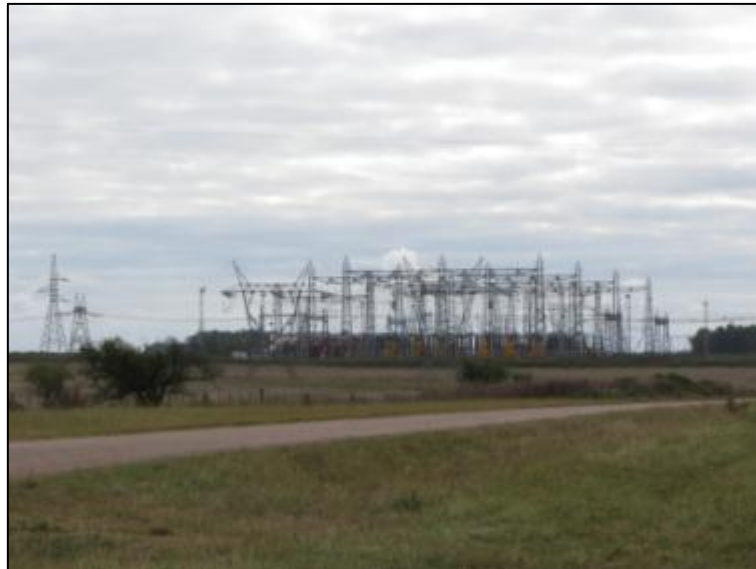
Ilustración 47 - Central reductora de UTE San Javier
