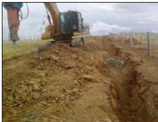
Ilustración 17 - Tendido de cable en zanja
