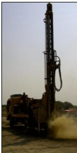
Ilustración 12 - Detalle de hincado de perfiles con maquinaria especializada
