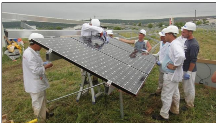
Ilustración 16 - Montaje de módulos.
