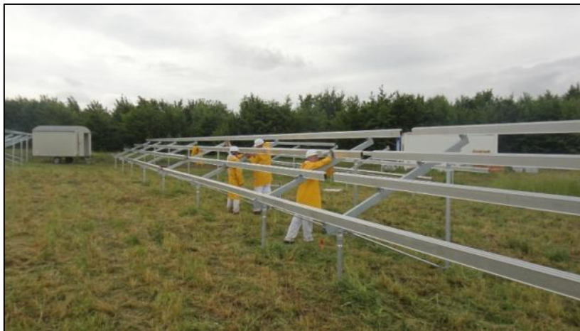
Ilustración 15 - Montaje de estructura fija con perfiles hincados directamente en el terreno
