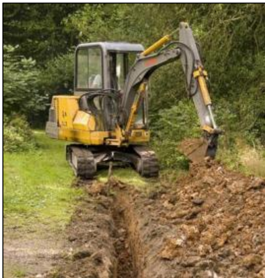
Ilustración 11 - Excavación de zanjas
