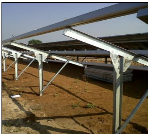
Ilustración 13 – Perfiles hincados directamente al terreno
