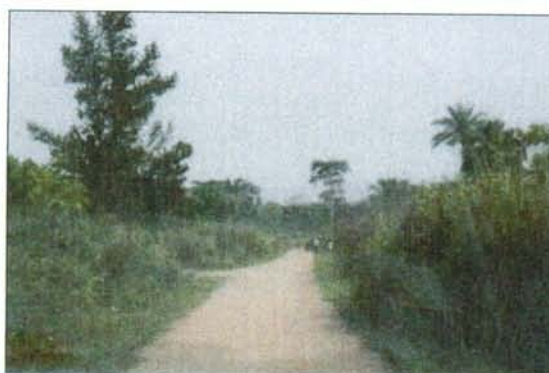
Photo 12 : Route d'intérêt public ouverte entre les villages de Bopuo et Mopepe
