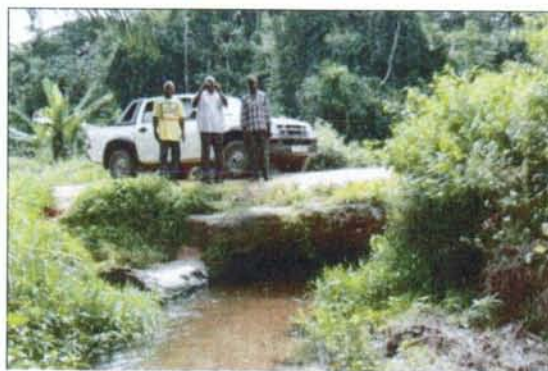
Photo 10 : Pont dans le village de Mbangi
